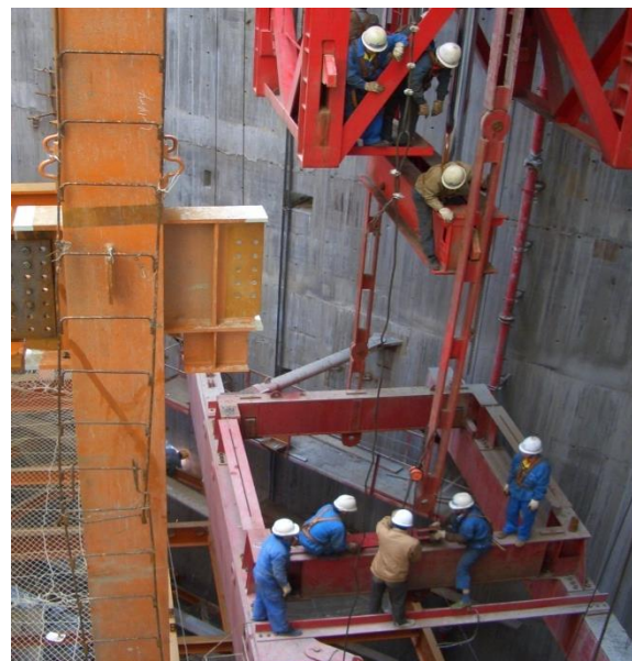
内爬塔吊爬升
