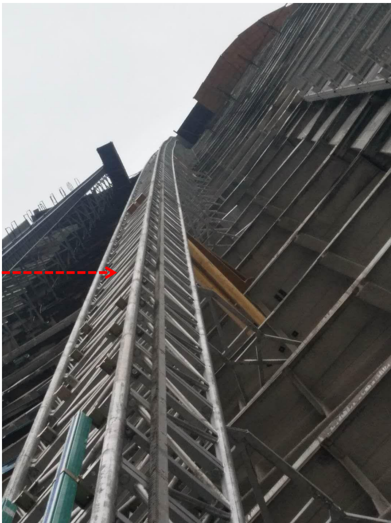
武汉绿地中心适应楼层微曲线
