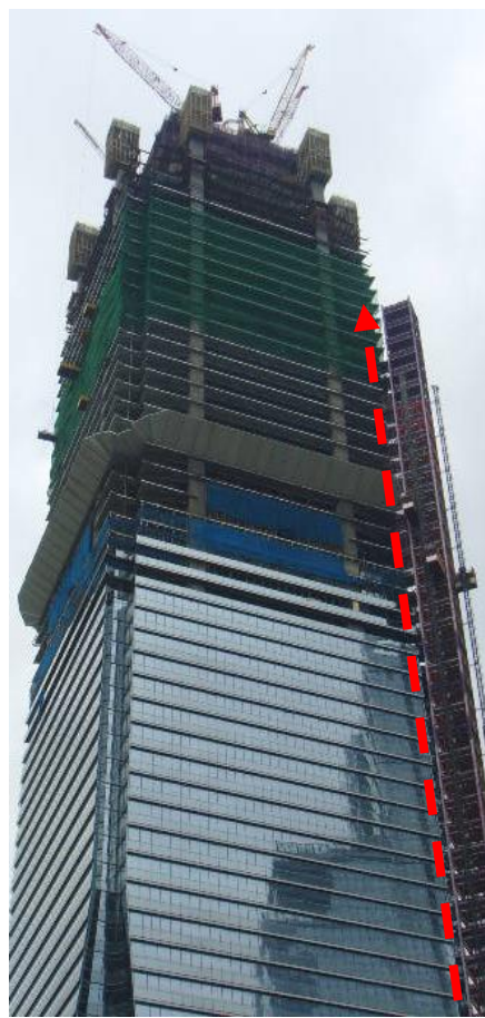
通道塔设置，设计安拆复杂，成本极高
