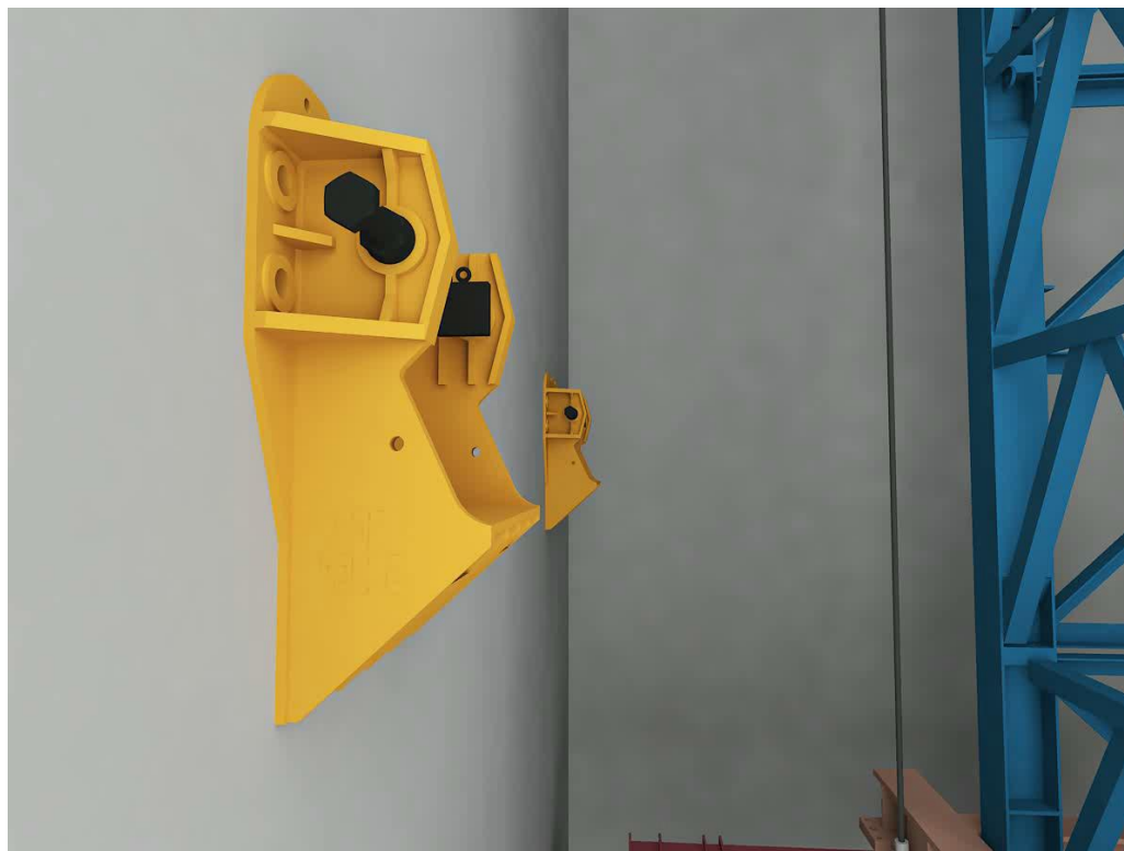
可翻转式支撑梁原理
