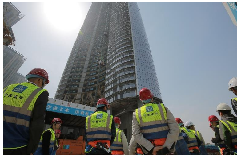
业主团队考察循环电梯
