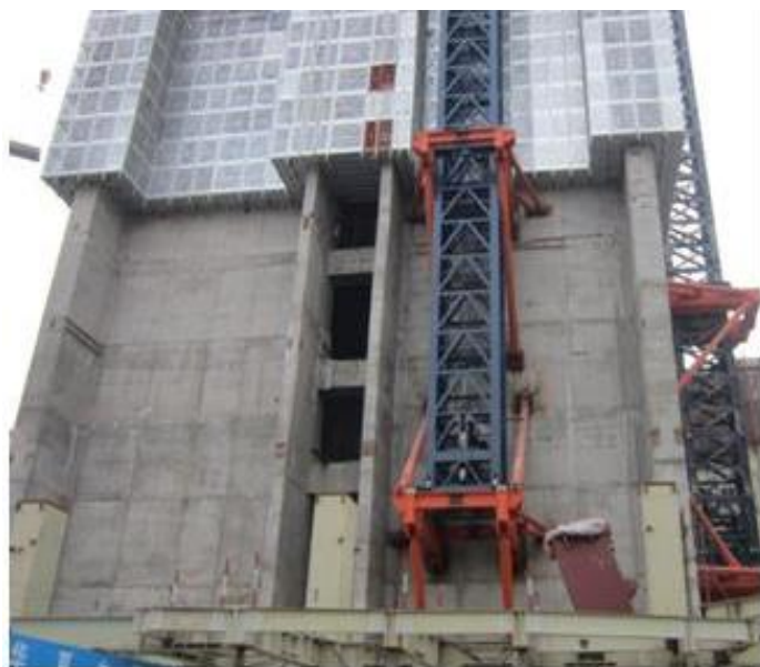
模架影响塔吊爬升
