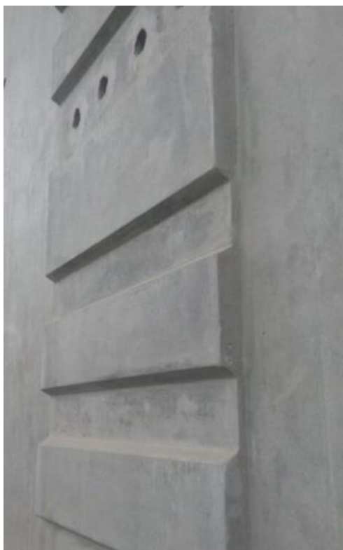
混凝土微凸构造
