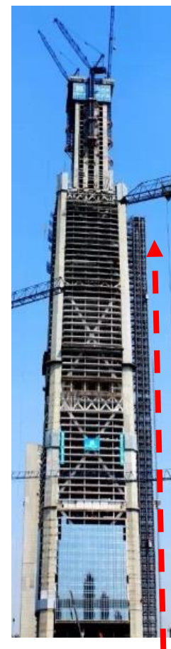
通道塔设置，设计安拆复杂，成本极高
