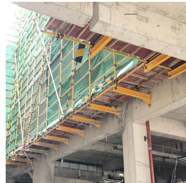
悬挑外架使用照片
